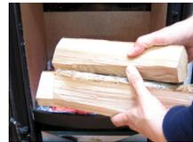
7. Bei einer Position der Luftzufuhr auf „Max.“ (offen) und geschlossener Tür zündet sich das neue Holz innerhalb weniger Minuten an.
