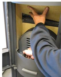
3. Sobald der erste Seitenstein aus dem Ofen ausgebaut ist, kann das Trennelement angehoben und ausgebaut werden.
