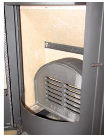
2. Mit einer Hand die untere Rauchleitplatte anheben und mit der anderen Hand den Seitenstein einige Zentimeter hochheben. Dazu eignet sich am besten ein Schlitzschraubendreher oder etwas ähnliches. Nach dem Anheben des Seitensteins das Trennelement wieder in Einbaulage zurückbringen, sodass der Seitenstein nun gelöst und herausgehoben werden kann.
