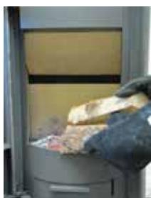
Il faut normalement toujours ouvrir la porte du poêle lentement les premiers 2 à 3 centimètres et attendre que la pression soit égalisée avant d'ouvrir complètement la porte. De cette manière, on évite d'être gêné par la fumée éventuelle, spécialement lorsque le tirage est mauvais.
