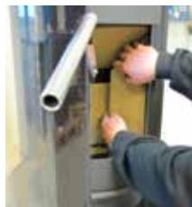
5. Libérez la chicane pour la fumée inférieure du boîtier d'air de combustion tertiaire et sortez-la.
