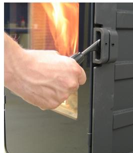
4. Når man kan se (efter 5-10 min.), at skorstenen er så varm, at der er træk igennem den, lukkes døren helt. Hvis alle forudsætninger er opfyldt, vil der efter yderligere ca. 15-20 min. være dannet et pænt glødelag i brandkammeret.
