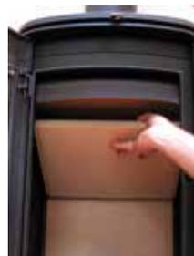
5. Retirez le déflecteur supérieur des supports, soulevez-le et sortez-le de la chambre de combustion.
