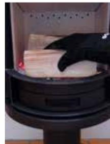
Sie sollten die Ofentür auf den ersten 2-3 Zentimetern langsam öffnen und dann abwarten, bis der Druck ausgeglichen ist, bevor Sie die Tür ganz öffnen. Auf diese Weise vermeiden Sie Rauchbelästigung, insbesondere in Verbindung mit schlechtem Schornsteinzug.
