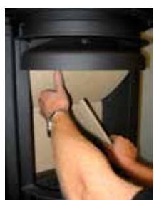
4. Nadat de stenen zijplaten en de achterstenen verwijderd zijn, schuift u het onderste rookschot naar beneden en verwijdert u het.
