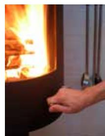
5. Si les conditions du point 4 sont remplies, mettre au maximum 2 bûches d'un poids total de 1,5 à 2 kg et d'une longueur de 25 à 30 cm à plat sur les braises, avec un espace d'env. 1 cm entre les bûches.
