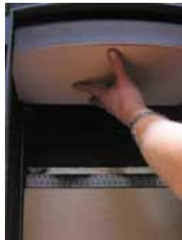
6. Man skal sikre sig, at røgledeplader og sten igen er korrekt monteret inden optænding efter en rensning.
