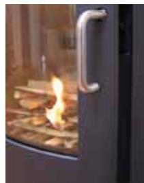
4. Når man kan se (efter 5-10 min.), at skorstenen er så varm, at der er træk igennem den, lukkes døren helt. Hvis alle forudsætninger er opfyldt, vil der efter yderligere ca. 15-20 min. være dannet et tykt glødelag i brandkammeret og der vil være en høj temperatur i brandkammeret, som er nødvendig for at kunne fortsætte forbrændingsfasen.
